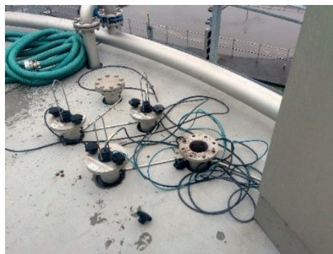
Rensning af N 2 O Wastewater Sensoren på toppen af rejektivandsbeholderen på VandCenterSyd, Odense
