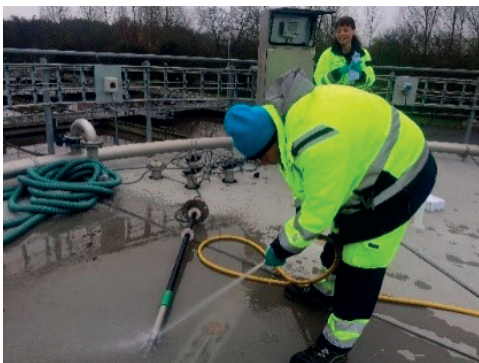
Rensning af N 2 O Wastewater Sensoren på toppen af rejektivandsbeholderen på VandCenterSyd, Odense
