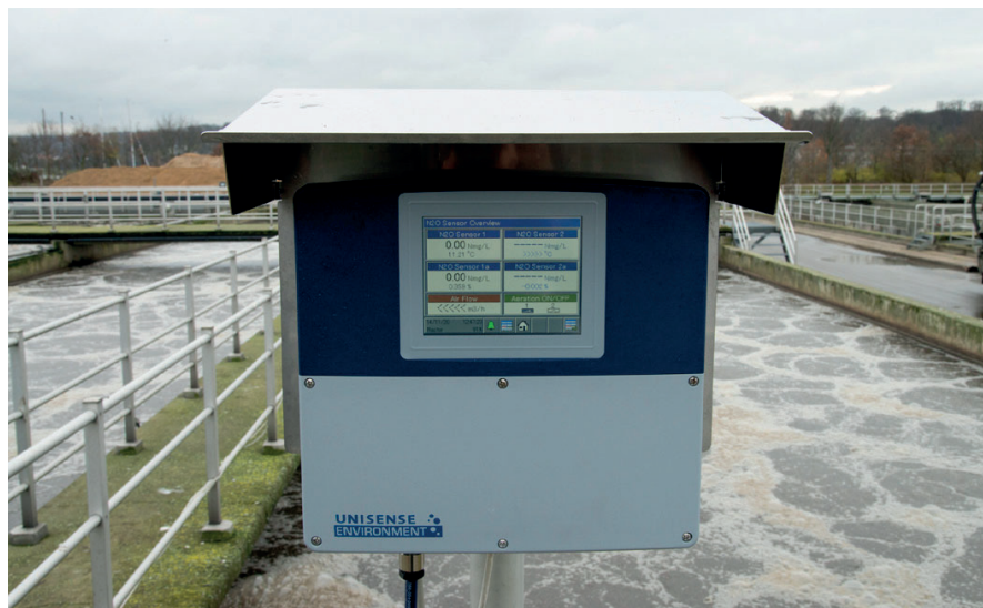
Ophæng af N 2 O Wastewater Controlleren ved brug af Pipe mounting kit og Weather protection canopy
