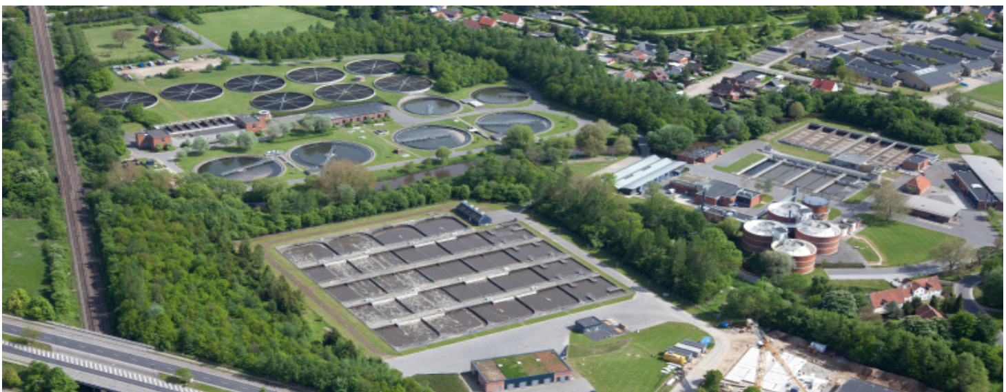
Ejby Mølle WWTP, photo: VCS Denmark
