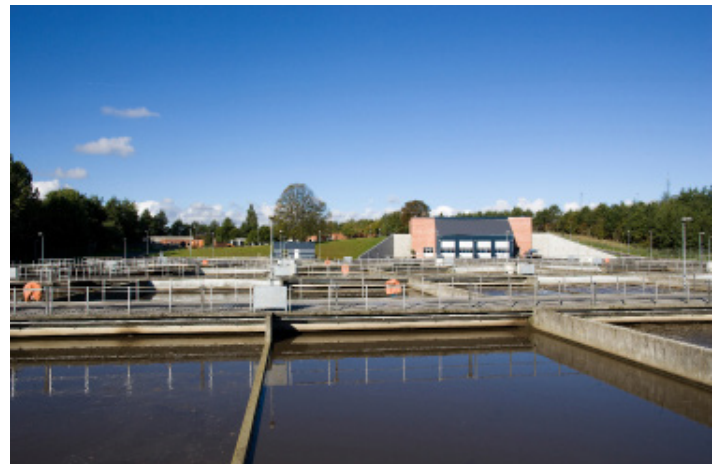
Ejby Mølle WWTP, photo: VCS Denmark
