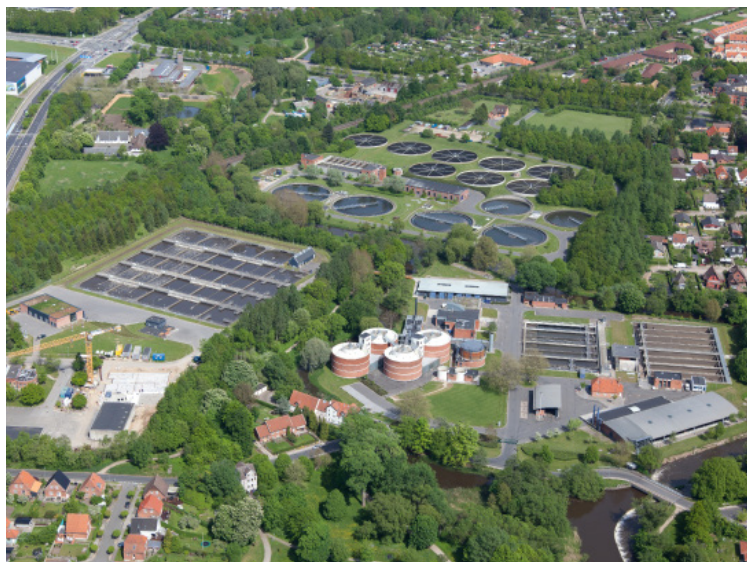
Ejby Mølle WWTP, photo: VCS Denmark
