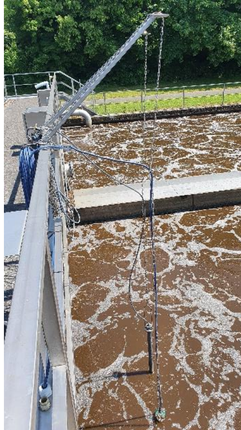
Eingebauter N 2 O-Sensor (Bochum)
