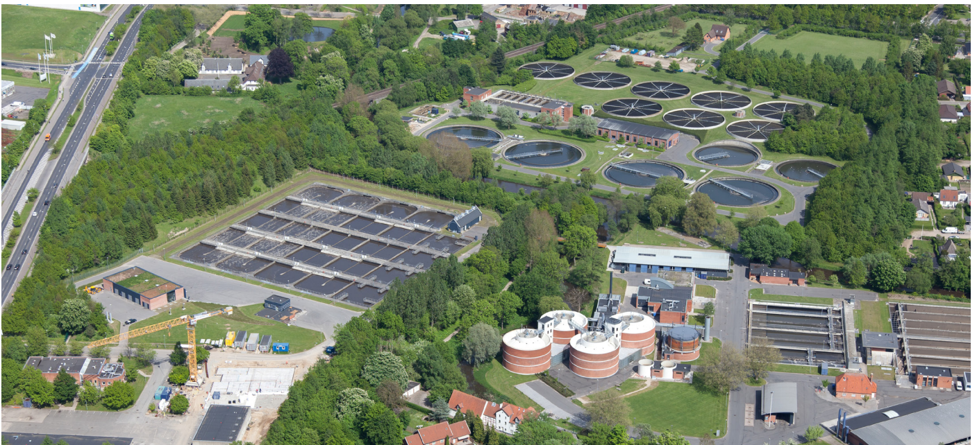
Kläranlage Ejby Mølle, Foto: VCS Denmark
