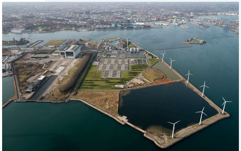
Fig. 1 : La station d'épuration de 750 000 EH de Lynetten, située dans le port de Copenhague
