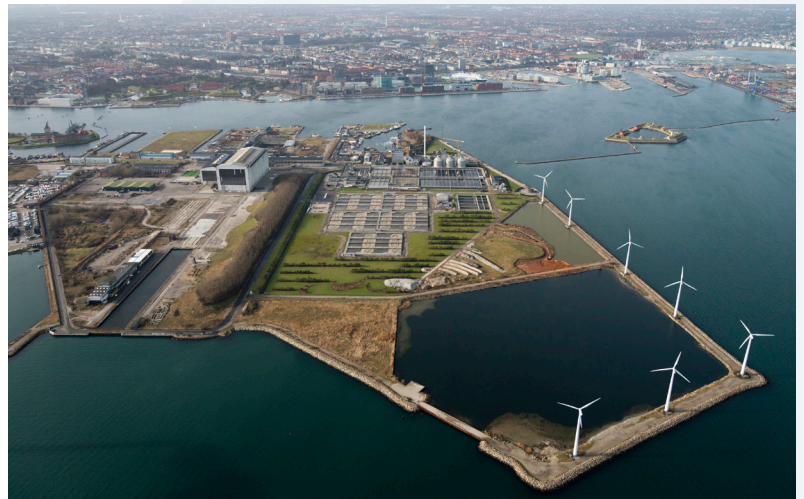
Fig. 1: L'impianto di trattamento delle acque reflue da 750.000 PE di Lynetten, situato nel porto di Copenhagen.
